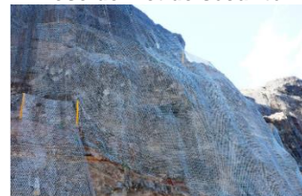
Pose de filet de sécurité
